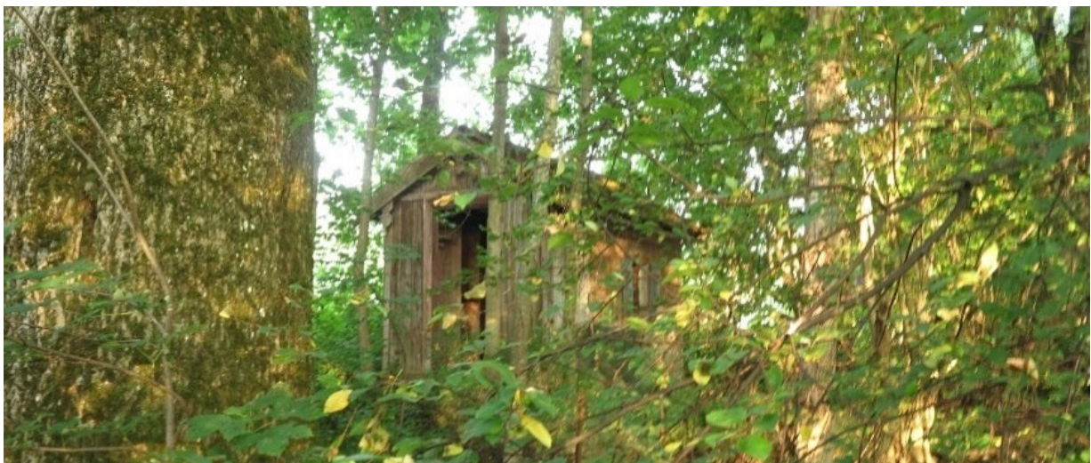
Abb. 13 verfallenes Gebäude im Westen des Feldgehölzes
