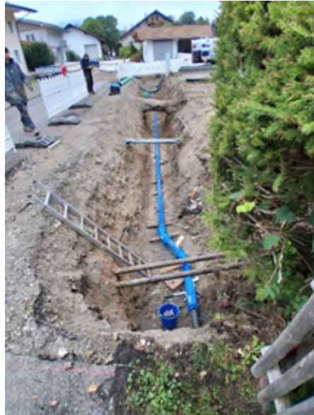
Sanierung Hauptwasserleitung DN100, St.Valentin
