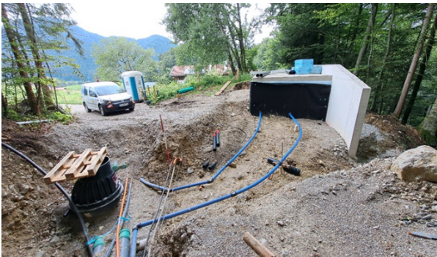
Neubau Pumphaus Zwickling
