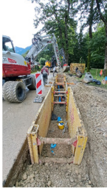
Sanierung Hauptwasserleitung DN150, Miesenbacherstr.-Hadermarkt-Grashofstr.
