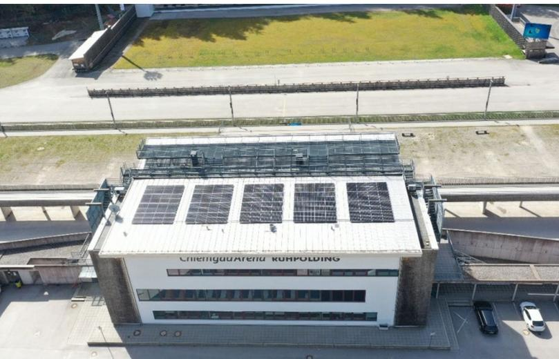
Bild 51: Auf dem Hauptgebäude wurden insgesamt 80 Module verbaut. An sonnigen Tagen kann das Haupt- und Funktionsgebäude, trotz der zwei großen Wärmepumpen, vollständig versorgt werden.
