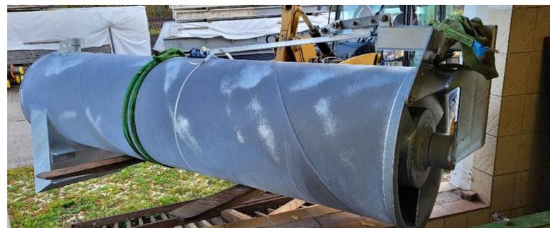
Bild 45 und 46: Austausch Rücklaufschlamm-schnecke
