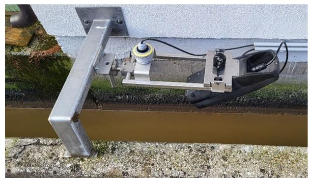
Bild 47: Erneuerung Zulaufmessung
