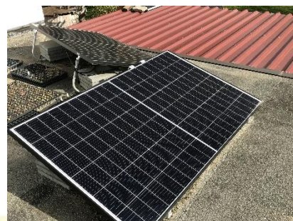
Balkonkraftwerk auf Garagendach © Energieagentur Südostbayern
